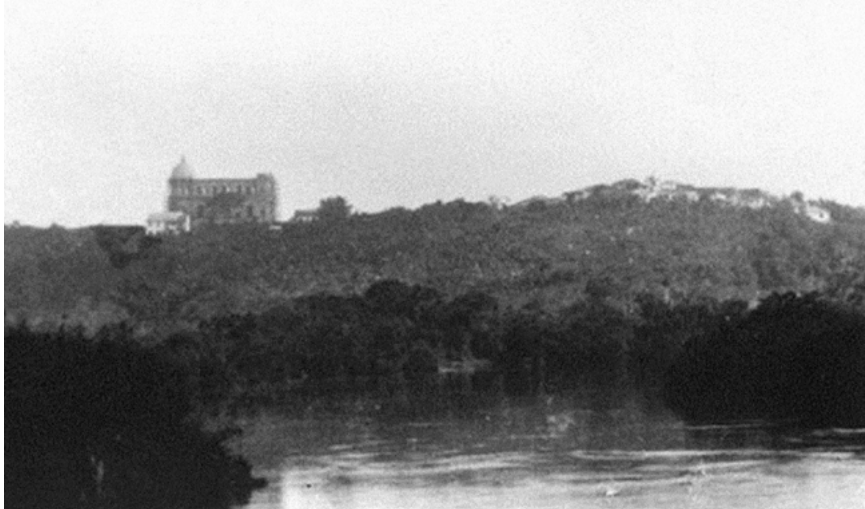
Igreja Nossa Senhora do Ó – margem direita do rio Tietê – finalização da obra (1900). Fonte: Acervo da Casa de Cultura Salvador Ligabue.
