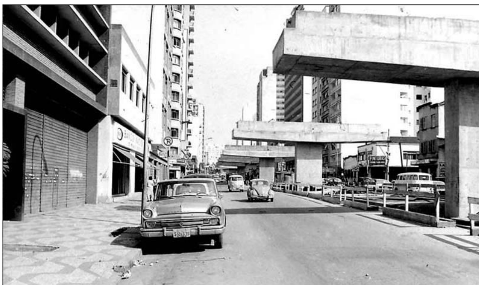
Situação de proximidade do elevado, em construção, com as edificações do entorno, em 1970. Fonte: Arquivo da PMSP. In: Assunção, 2016, p. 122.
