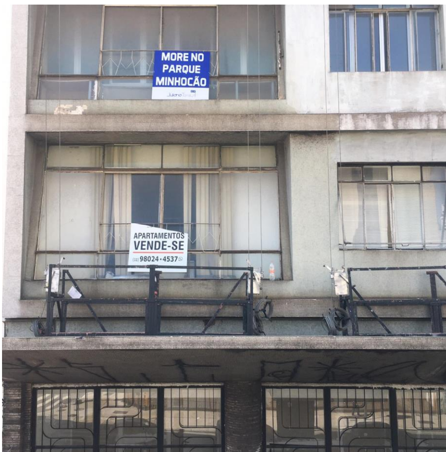
Imagem apartamento no entorno do Minhocão com placa vendendo apartamento no Parque Minhocão. Foto: Gabriel Fernandes, 2019.
